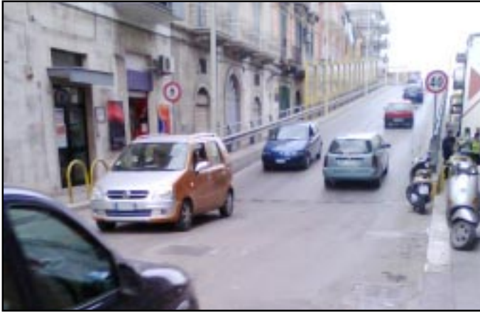
Il ponte di Via Canosa. L'asfalto non è in buone condizioni
